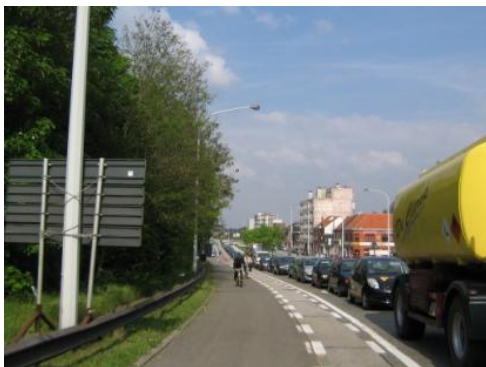
Foto 16: Fietsvoorzieningen op brug (Kanaalstraat)
